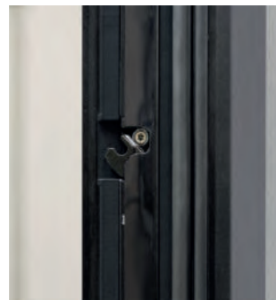
Der Verschluss mit pferdekopfförmiger Verriegelung im Rahmen
